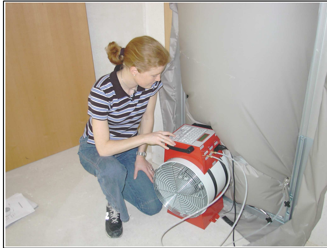
Messung der Luftdichtheit im Über- und Unterdruckverfahren
